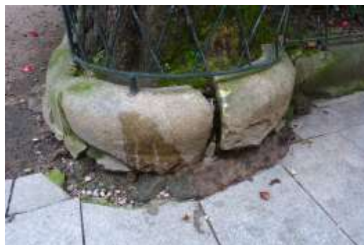
Bases dos fustes sen espazo para desenvolverse e parte do sistema radical baixo as lousas de pedra
